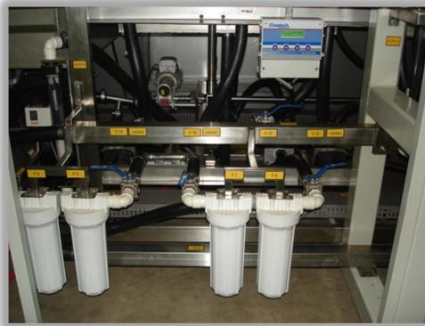
Sistemas de Recirculação com Filtragem compostos por filtros duplos do tipo cartucho equipam a Lavadora os quais são dotados de identificação de saturação por fluxostatos. A Lavadora também conta com Sistema de Dosagem Automatizada de produto químico e geração de água Deionizada.
