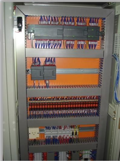
Painel elétrico duplo com divisão das partes de Comando e Potência. CLP marca Siemens, família 1200 de última geração. IHM Touch Screen família KTP da Siemens montada na porta frontal do Painel elétrico de comandos. Sistema com disponibilidade de 10 programas (receitas) de lavagem diferentes com ajustes de parâmetros independentes e senha de acesso para Administrador. Programa de CLP desenvolvido pela própria CTA com flexibilidade de adequações ao processo do cliente.
